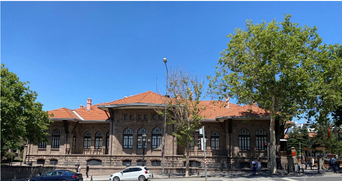
튀르키예 대국민의회 건물
