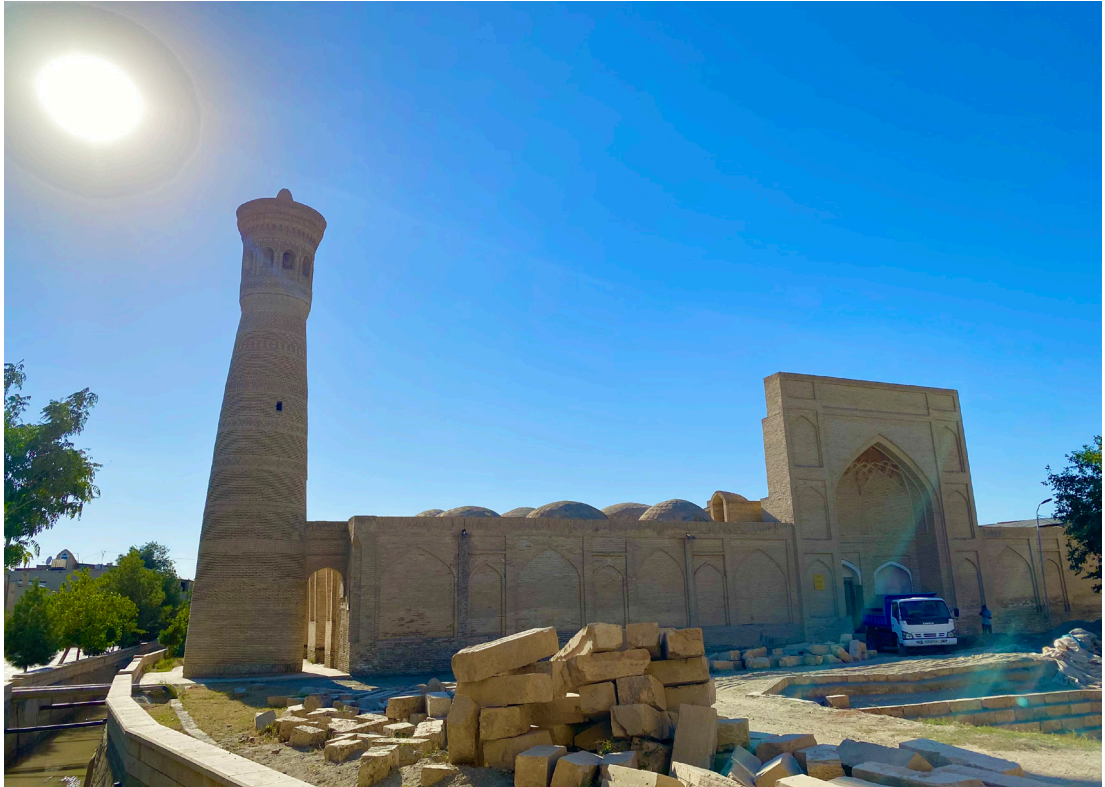
복원 공사 중인 거브쿠션 복합단지
