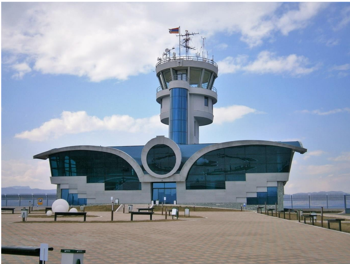
Şəkil 2.4.2 Xocalı Havalimanı
