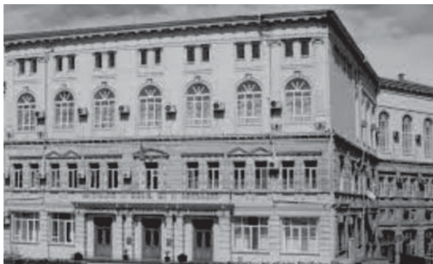
Здание, где проходил Второй съезд партии «Мусават» (ныне здание Конституционного суда)
