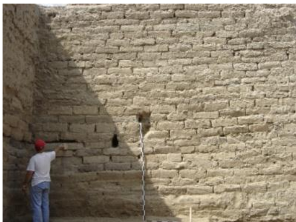
3. Qalatəpə. İctimai binanın divarlarının görünüşü
